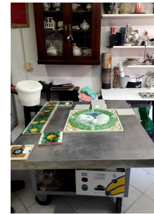
Smontaggio e rimontaggio paramento ceramico del fonte
