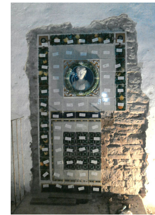
Smontaggio e rimontaggio paramento ceramico del fonte
